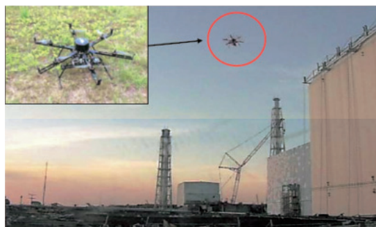
ドローンによる福島第一タービン建屋屋根の線量調査
