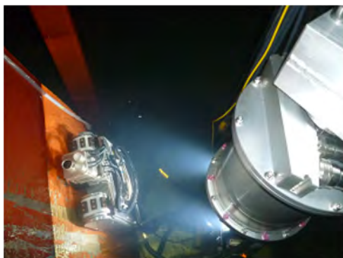
写真1 モックアップ試験の様子 (2013年9月)
