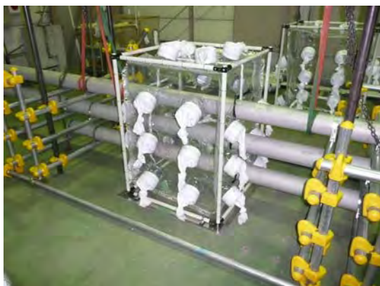
写真4 配管にグローブボックスを取付けた状態
